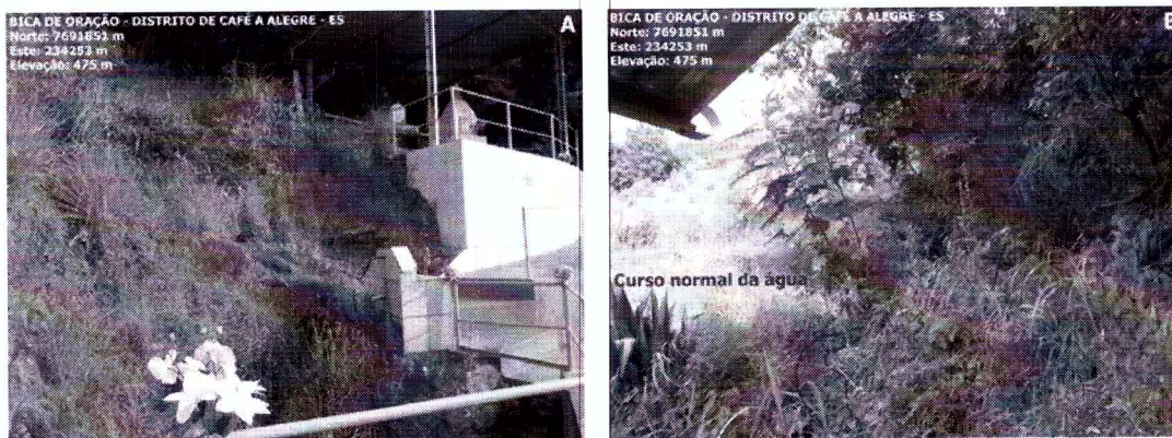
Figura 15 – Bica de Oração localizda as margens da rodovia ES – 181. Data: 17/01/2015.
